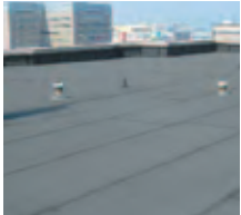
露出アスファルト
