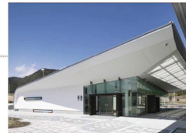
清水パーキングエアポートII 設計:中日本高速道路株式会社 株式会社筑城建築都市デザイン事務所 設計:中村邦子エントラ 撮影:ナカガワノブアキ 商品名:ジョリパットネオ 仕上げ:特殊フラット仕上げ(T1000)
