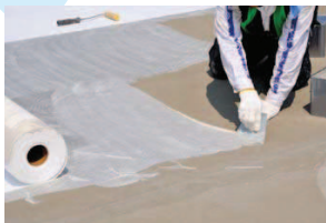
接着剤(ブルーフロンNT-FエコボンドH)の施工
