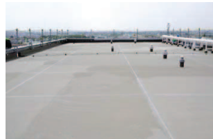
下地処理完了
