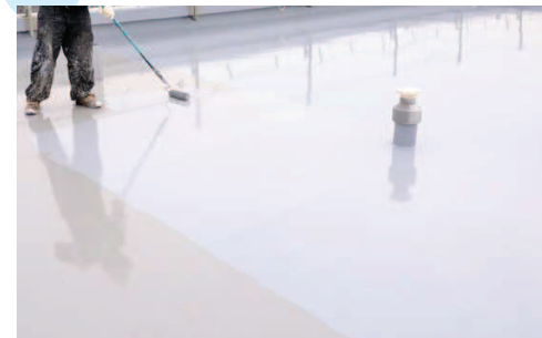
各種トップコートをローラー・刷毛で施工してください。
