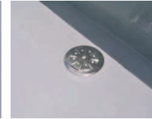
通気緩衝工法は脱気筒、または脱気盤の設置が必要となります。
