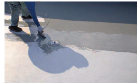
防水材の施工(1層目)
