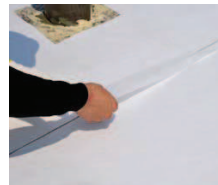
通気緩衝シートのジョイント処理(ブルーフロンNT-Fジョイントテープ)の施工
