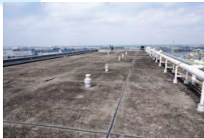
屋上防水改修施工前
