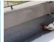
立上がり部はNSタイプを使用するか、増粘剤を調合した平場用ウレタン防水材で施工してください。
