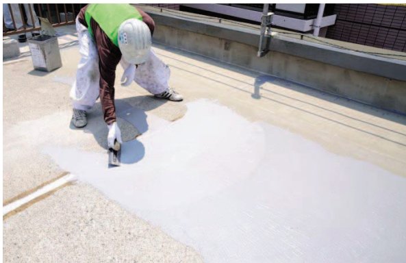
下地処理では必要に応じ、NTカチオンタイトFなどで下地処理を行なってください。
