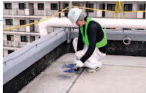
清掃・突起物 などの処理
