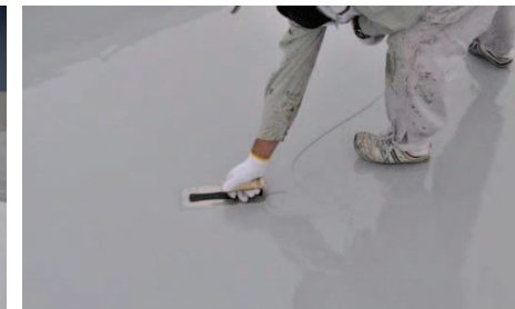
防水材の施工(2層目)
